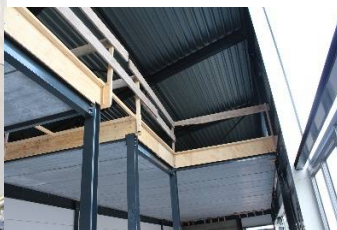
Een doorkijkje naar de verdieping
